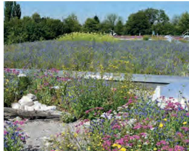
Das Biodiversitätsgründach bietet einen hohen Mehrwert für die Natur. Neben einer üppigen Bepflanzung können hier zusätzliche Mikrohabitate wie etwa Totholz, Steinhaufen und Freiflächen aus Sand oder Kies angelegt werden.
