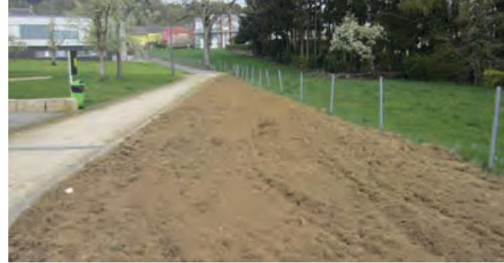
Der Boden wurde aufgefäst und neu eingesät, April 2017.
