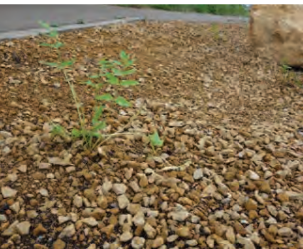
Der Boden wurde mit Kalkschotter der Körnung 0-16 mm ausgetauscht. Initialstauden wurden neben der Einsaat gepflanzt.
