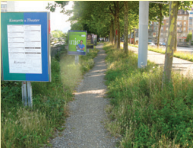
Trottoir en concassé à Zürich (Suisse).
