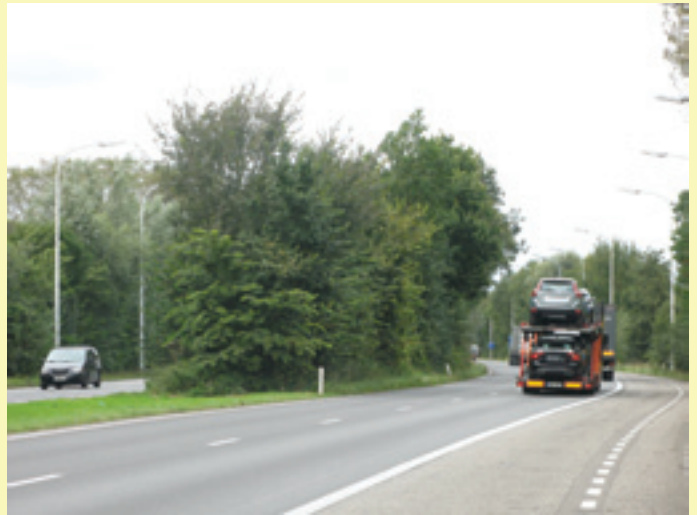
Même si la bande centrale ne présente qu'une petite largeur, il y a moyen d'y développer une végétation ligneuse d'une certaine envergure (effet anti-éblouissant, limitation de l'effet de fragmentation).
