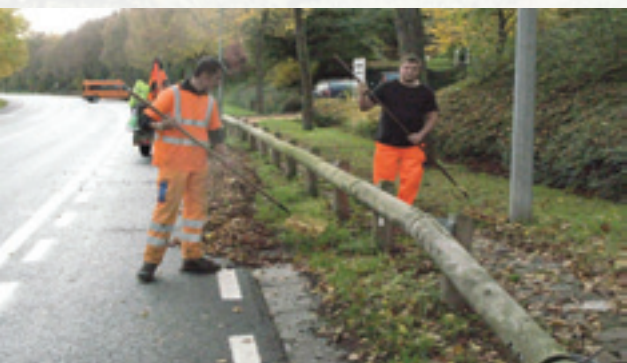
Exemple positif: Lors du nettoyage des surfaces de circulation, il faudrait renoncer au recours à des engins motorisés.
