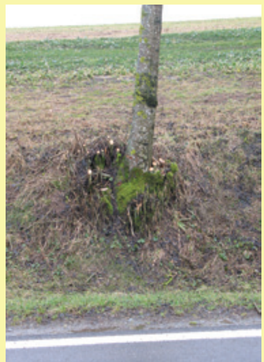
Exemple négatif: Dénudation du talus en dessous des arbres
