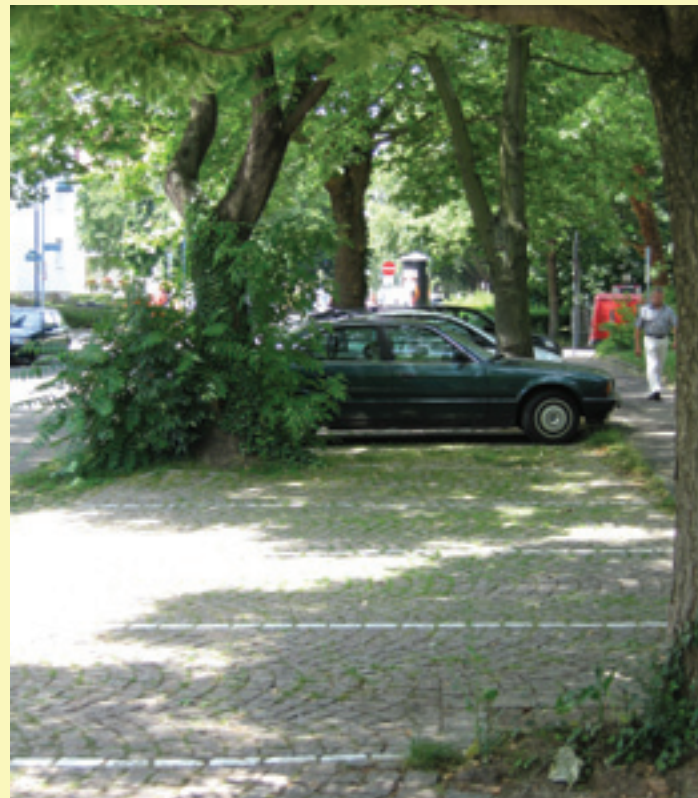
Ancien parking dans un pavement traditionnel à Freiburg-im-Breisgau .
