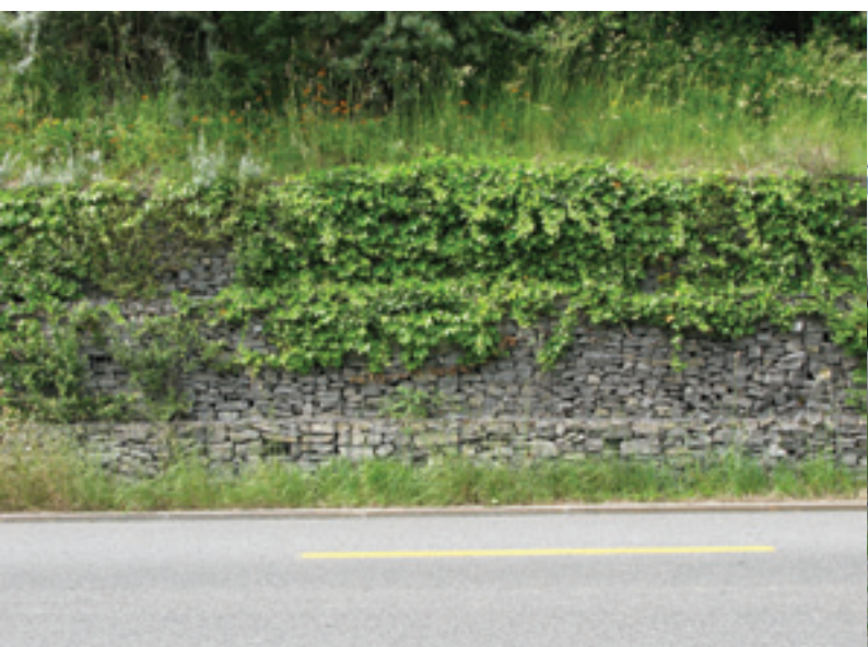
Mur en gabions à Lucerne (Suisse).
