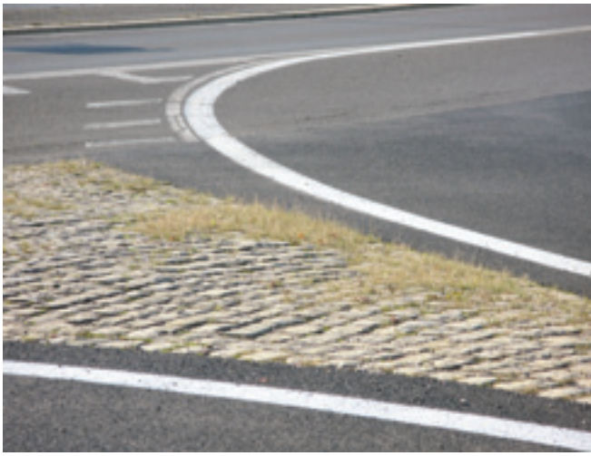
Exemples positifs: Ilots dans la route, formés de pavés posés ou non dans le mortier, mais ayant pu se couvrir de végétation herbacée par succession naturelle.
