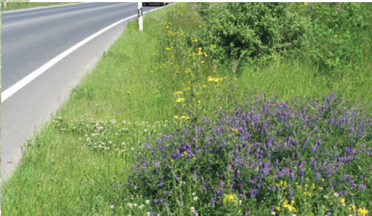
Exemple positif: Si les abords des routes sont entretenus de manière extensive, ils peuvent avoir la fonction de couloirs écologiques.
