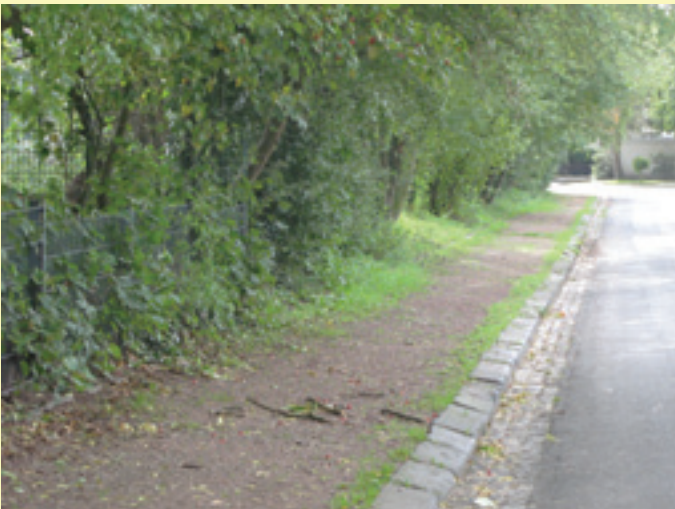
Trottoir en concassé à Herne (Allemagne).
