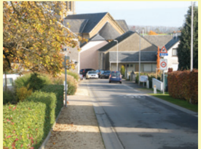
Trottoir en concassé à Arlon (Belgique).
