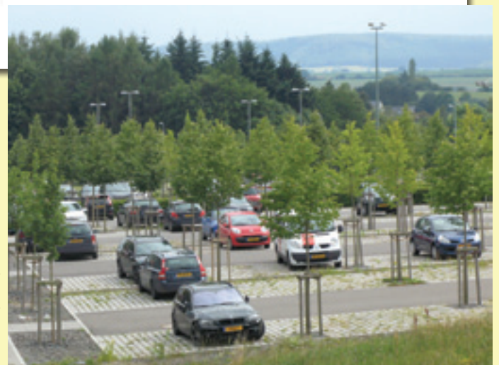
Parking écologique près du lycée de Rédange. Les arbres plantés dans le substrat maigre commencent à former un toit de couronnes au-dessus des voitures stationnées. Depuis l'arrêt de l'épandage d'herbicides et l'entretien par flambage, s'est installée spontanément une riche végétation herbacée naturelle comportant des plantes rares telles que le thym.
