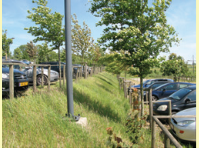
Parking écologique près d'un centre commercial à Weiswampach. Un parking écologique permet de s'adapter particulièrement bien à un terrain en pente.
