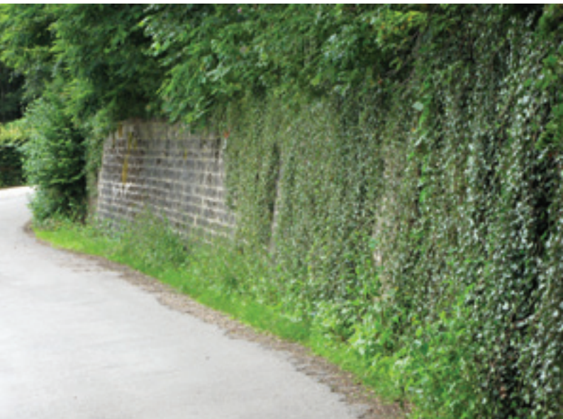
Mur en maçonnerie conventionnelle (avec ciment en mortier) à Thillsmillen entre Kopstal et Mamer.
