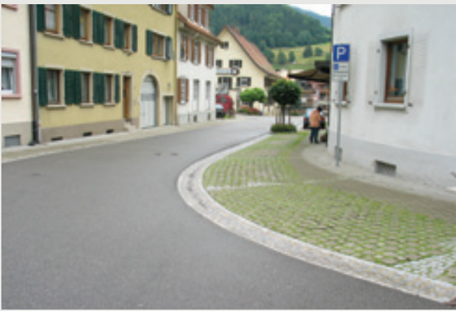
Exemple positif: Schönau (Allemagne). Espace entre la chaussée et les maisons exécuté dans un substrat maigre, à savoir des systèmes alvéolaires.
