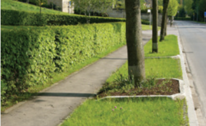
Exemple négatif: La bande de stationnement étant réalisée en dalles alvéolaires, il aurait été avantageux de renoncer à l'aménagement de plates-bandes avec arbres, délimitées avec des bordures, remplies de terre arable et couvertes de copeaux d'écorce. Les arbres auraient dû être plantés directement dans les dalles alvéolaires.
