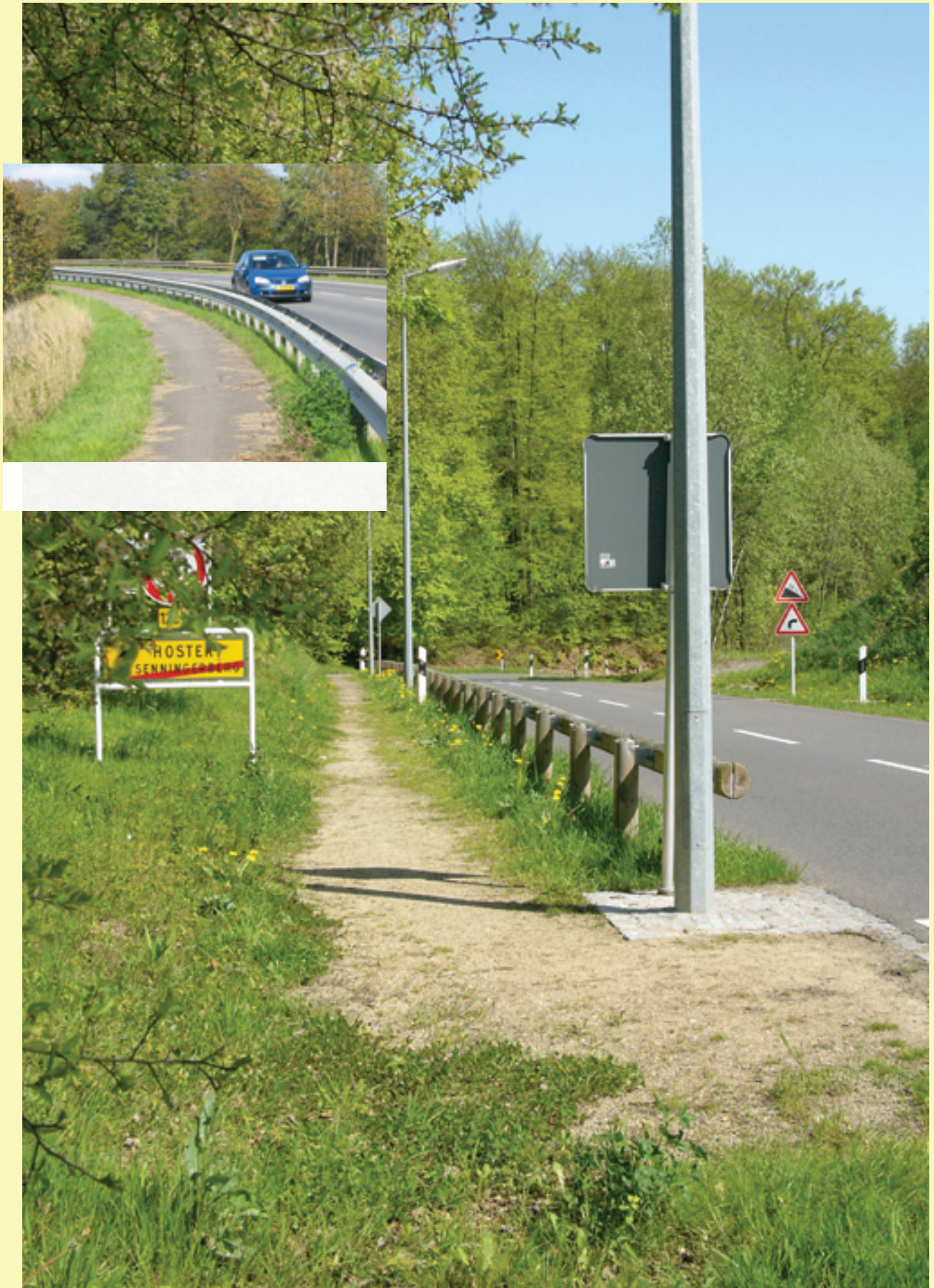
Trottoir en concassé à Senningerberg. La glissière est posé dans le même concassé celui du trottoir.
