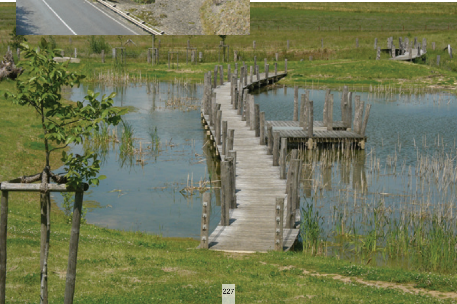
Exemple positif: Bassin de rétention à Frisange, aménagé suivant des critères écologiques dans le cadre des mesures compensatoires pour la route de liaison avec la Sarre.
