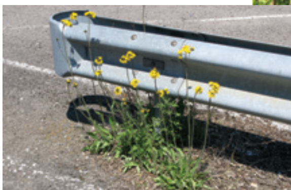
Exemple positif: Parking écologique à Merl: biodiversité le long d'une glissière en métal posée dans l'asphalte.
