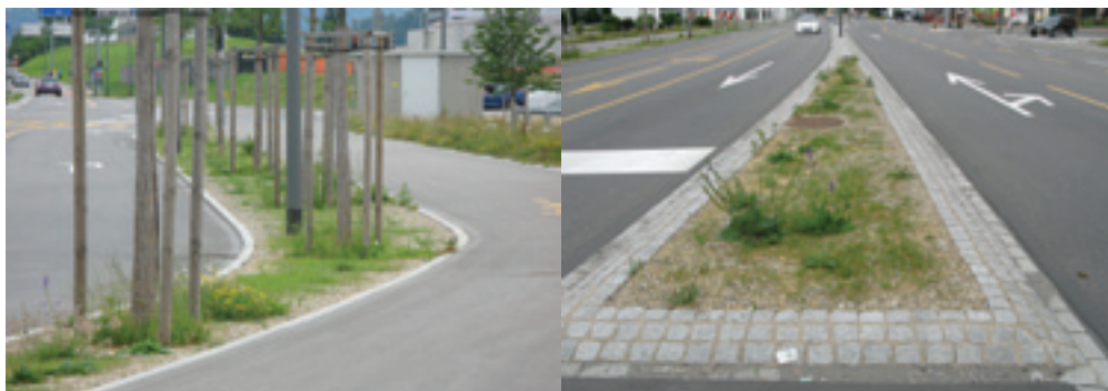
Exemple positif: Récent aménagement routier avec îlots et plates-bandes en concassé à Lucerne (Suisse).
