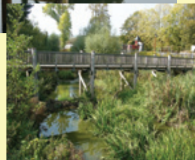
Pont piétonnier à Pétange.
