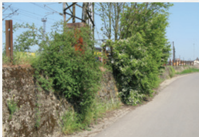
Exemple positif: Mur en maçonnerie traditionnelle à Bettembourg : l'installation de végétation ligneuse sur le mur ne conduit pas toujours à des problèmes de stabilité, dans la mesure où les racines peuvent former avec les pierres une entité stable.
