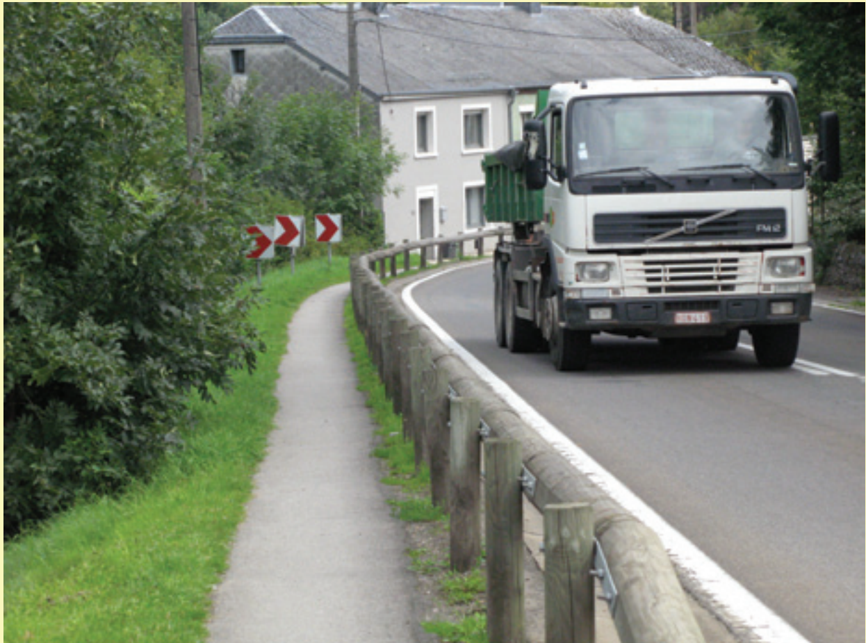
Trottoir en asphalte derrière glissière en Belgique. La glissière est posé dans le concassé (et non dans la terre organique)
