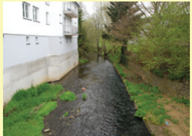
Augmentation de la capacité hydraulique et développement de la végétation aquatique suite à l'élargissement du cours d'eau par enlèvement du mur de soutènement.
