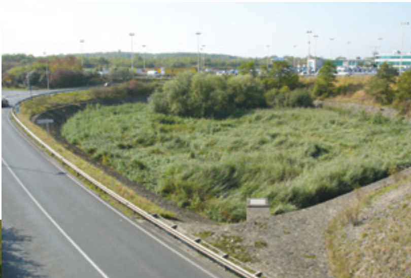
Bassin de rétention à Gasperich. Aménagé de manière conventionnelle, c'est-à-dire avec des berges en béton, il a cependant pu se couvrir de végétation naturelle grâce à un entretien suffisamment extensif.
