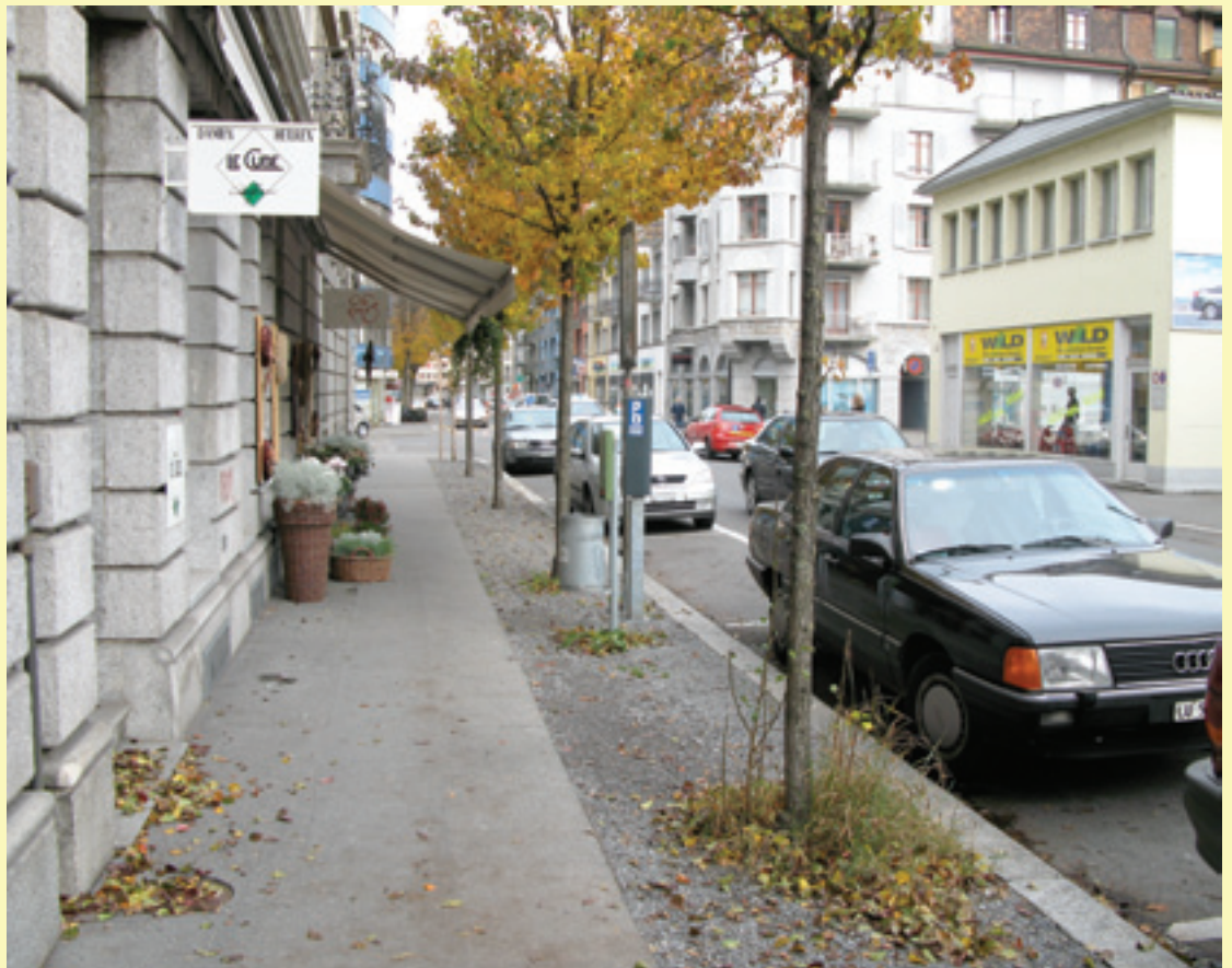
Exemple positif: Plate-bande avec arbres dans un trottoir à Lucerne (Suisse). Malgré la forte fréquentation du trottoir, la plate-bande est réalisée en concassé susceptible de se couvrir spontanément de végétation herbacée.
