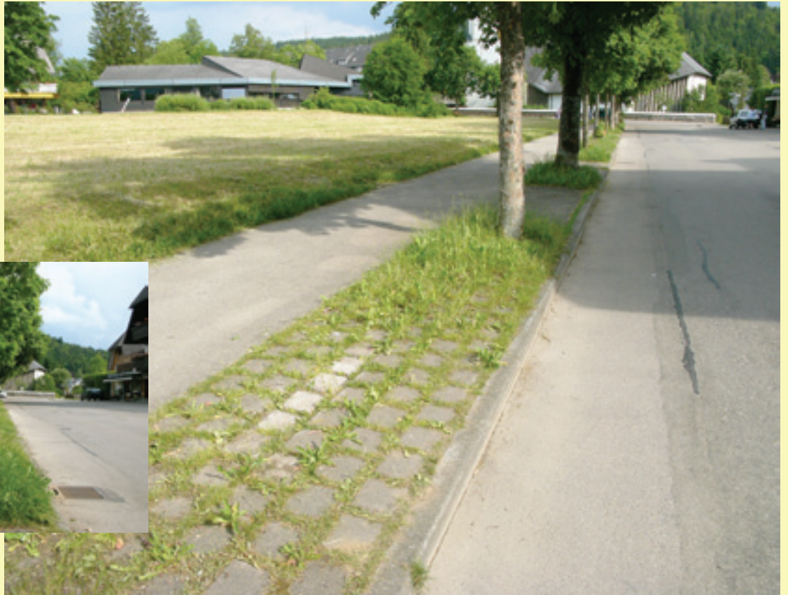
Exemple positif: Plates-bandes en pavés non posés dans le mortier à Hinterzarten (Allemagne), permettant la croissance des arbres et de la végétation herbacée, mais facilitant aussi la circulation des piétons. Si un véhicule s'y égarait par inadvertance, il ne créerait pas d'ornières.
