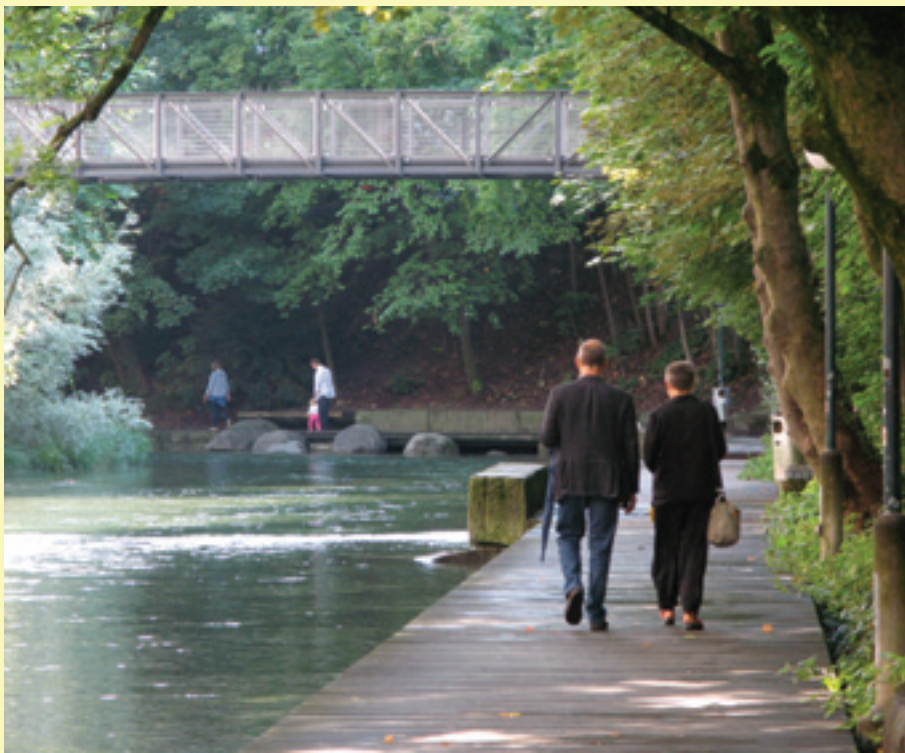
Chemin sur pilotis en milieu urbain à Zürich (Suisse). Il se situe à une vingtaine de centimètres au dessus du niveau de l'eau du cours d'eau. En période de crue il n'est pas accessible. Il a été renoncé à l'installation d'un garde-corps.
