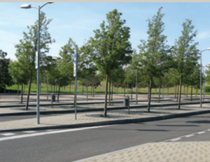
Exemple négatif: Réalisées entièrement en pavés, les surfaces de circulation ne peuvent pas se couvrir d'une végétation herbacée naturelle en raison de l'épandage d'herbicides.
