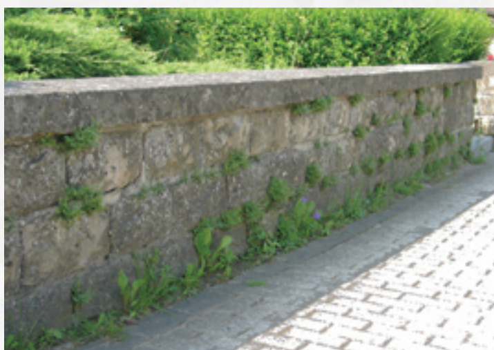
Exemple positif: Mur en maçonnerie conventionnelle avec une importante végétation composée de fougères dans les fissures du mortier, et avec une bande herbacée à son pied. Un tel mur ne devrait pas subir de réparation à ce stade, étant donné que les petites modifications du ciment ne remettent pas en question ni la stabilité du mur, ni sa fonction.
