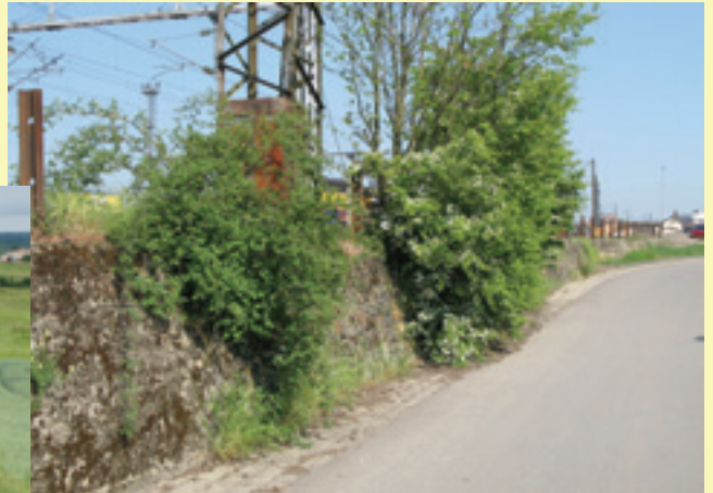
Mur à Bettembourg
