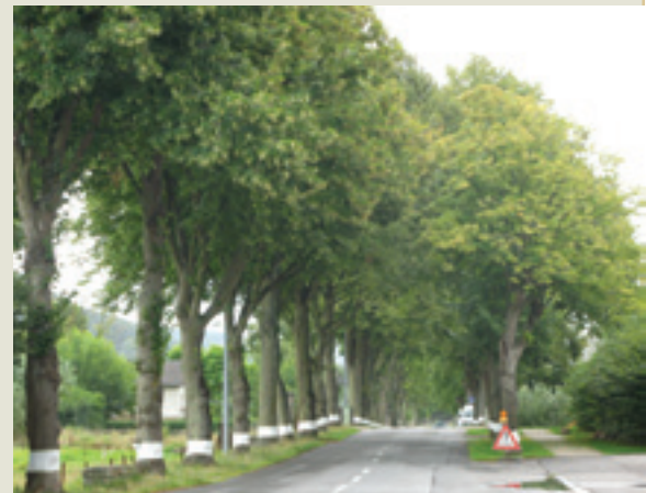
Elagage exagéré d'une allée entre Mersch et Gosseldange: la hauteur de l'élagage ne devrait pas dépasser la base de la couronne.
