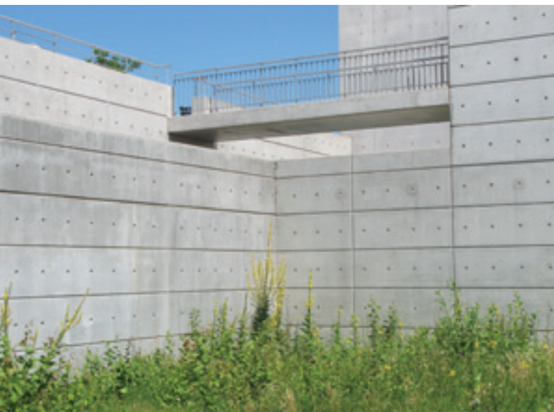
Mur en béton constituant la paroi d'un bâtiment contemporain au Kirchberg.
