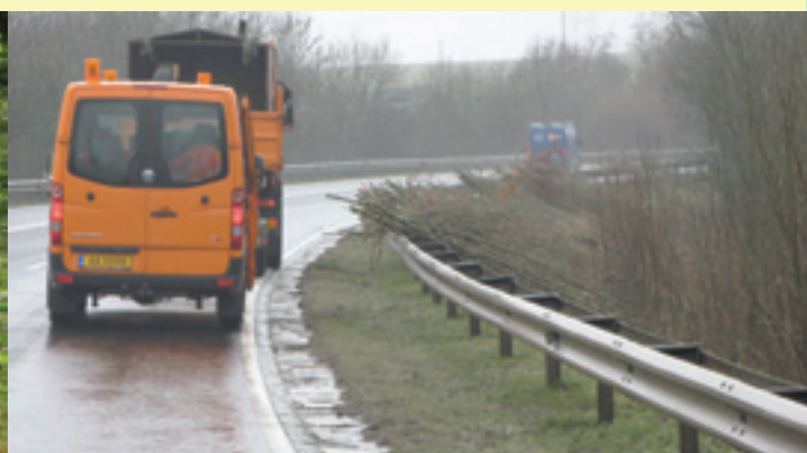
Débroussaillage le long de la route nationale N7 pour restaurer la visibilité dans un virage. Il aurait été préférable d'empêcher dès le début l'installation de végétation ligneuse par un fauchage dans la zone de visibilité intervenant une fois tous les deux à cinq ans.
