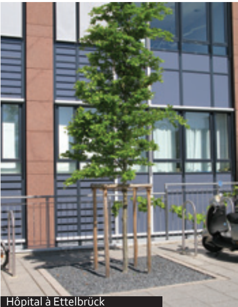
Hôpital à Ettelbrück
