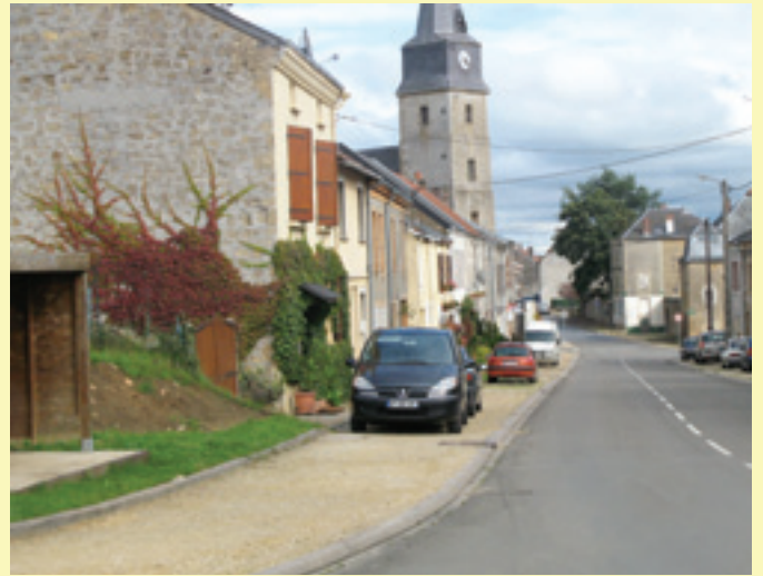
Trottoir en concassé à Messincourt (France).
