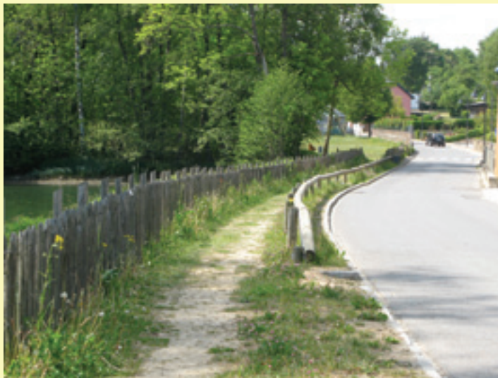
Trottoir derrière glissière à Beckerich.
