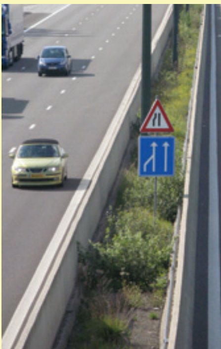
La surface en scories entre les murs californiens s'est couverte spontanément de végétation ligneuse qui peut exercer un effet anti-éblouissant..
