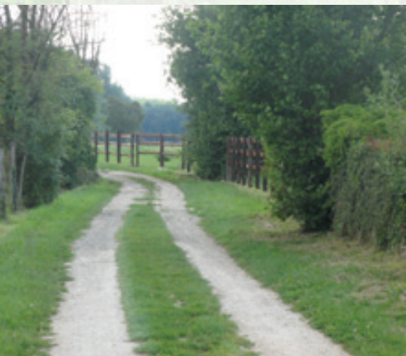
Exemple positif: Chemin rural à Busancy (France), réalisé en concassé et couvert de végétation herbacée qui s'est installée spontanément.
