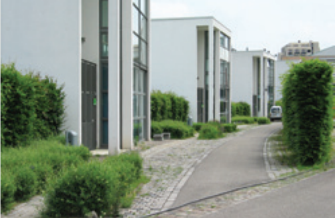
Exemple positif: Lotissement écologique à Sarrebrück (Allemagne). Le trottoir, la plate-bande et la bande de stationnement sont réalisés dans un même substrat maigre, à savoir des pavés non posés dans le béton.
