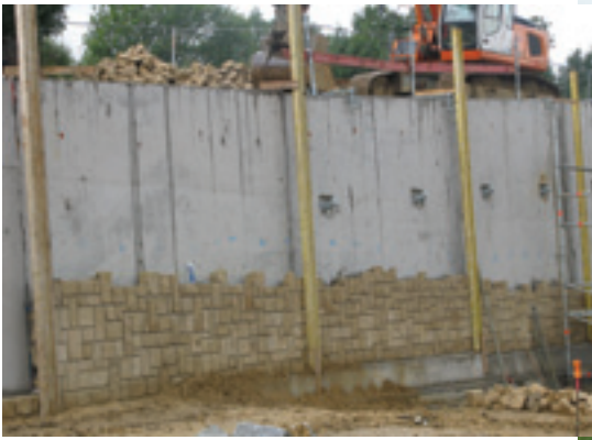
Exemple négatif: Faux-murs en maçonnerie. Il aurait fallu renoncer au revêtement du mur en béton, en premier lieu pour des raisons d'économie. Il faudrait construire ou bien un mur en maçonnerie (sèche ou traditionnelle) ou bien un mur en béton apparent.
