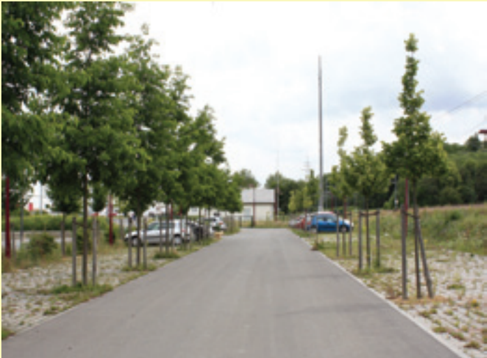
Parking écologique près de la gare à Bascharage. Les emplacements sont réalisés dans un pavé contemporain, alors que le chemin d'accès est exécuté en asphalte.
