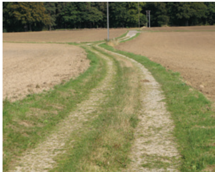
Chemin rural en concassé rudimentaire (structure monocouche).
