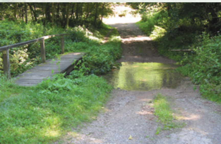
Exemple positif: Le passage d'un chemin forestier à travers un cours d'eau devrait se faire au moyen, non pas d'un pont reposant sur des culées, mais d'un gué. Etant donné que les chemins forestiers ne sont utilisés que par des engins lourds, le gué ne devrait pas poser de problèmes de circulation.
