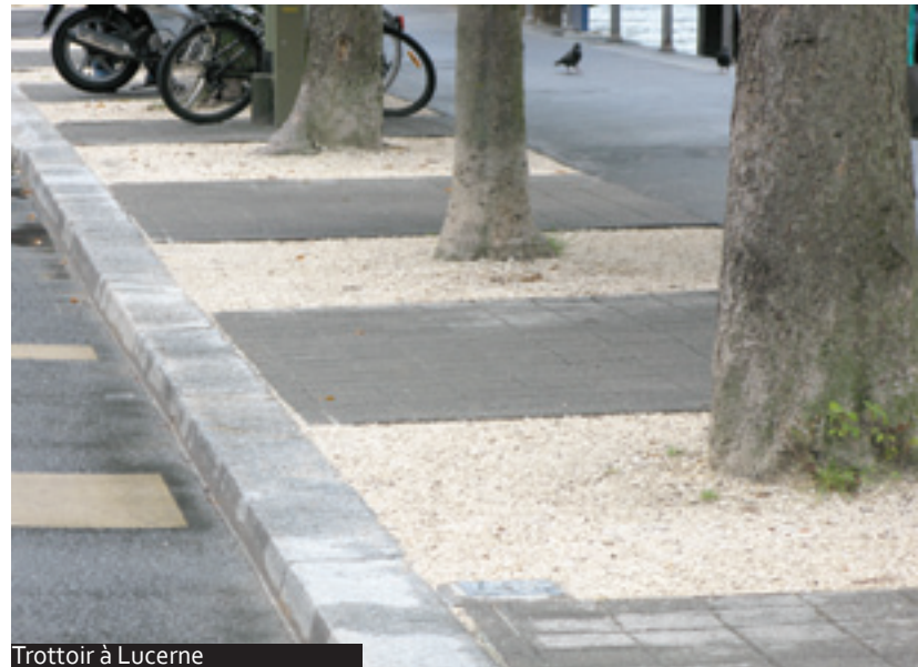
Trottoir à Lucerne
