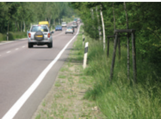
Accotement («Summerwé») le long de la route de Luxembourg à Leudelage. Réalisé en concassé (ou en scories), il peut se couvrir spontanément d'une végétation herbacée naturelle.
