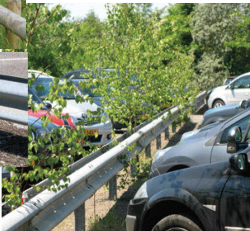
Exemple positif: Parking écologique à Merl: le long de la glissière laquelle se sont installés spontanément des arbres, alors qu'elle est posée dans l'asphalte.
