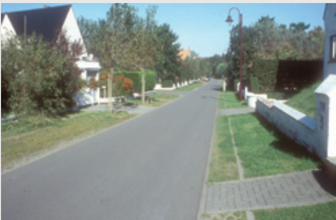
Exemple positif: Haan (Belgique). Trottoir et bande de stationnement en substrat maigre.
