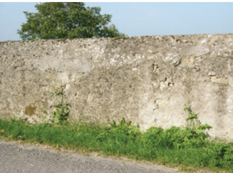
Mur en maçonnerie traditionnelle (avec ciment en calcaire) à Herborn.
