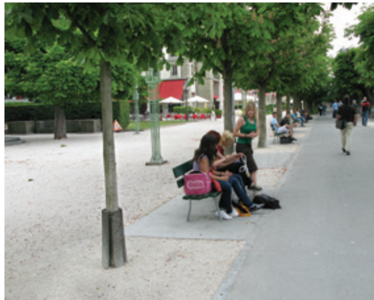
Esplanade à Lucerne (Suisse) en concassé hautement élaboré (structure multicouches).
