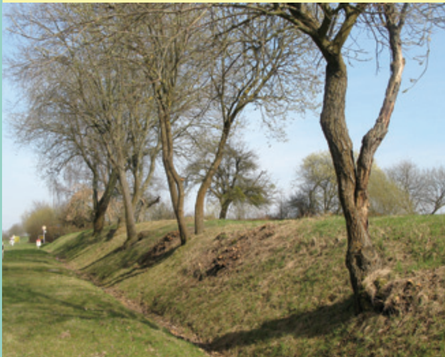
Exemple négatif: Entretien exagéré d'un talus le long d'une route.
