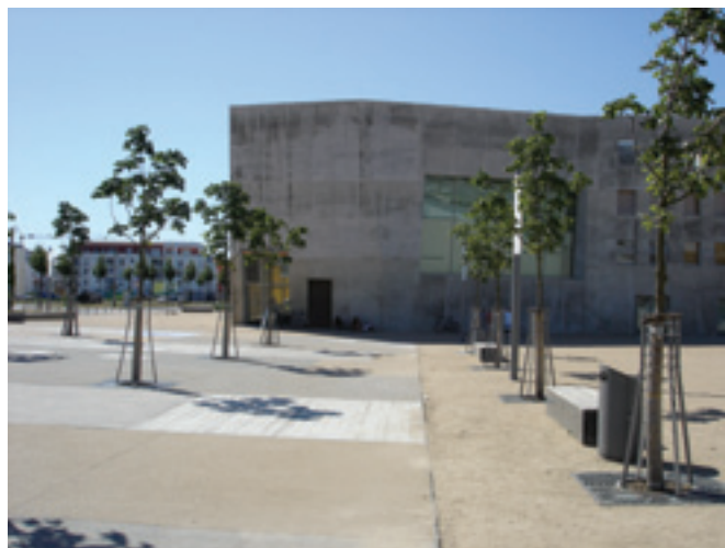
Exemple positif: Place piétonne à Freiburg im Breisgau (Allemagne), réalisée dans un concassé de haute qualité pour répondre aux exigences techniques et esthétiques en plein milieu urbain. Une végétation herbacée naturelle peut s'y installer spontanément aux endroits moins sollicités par la circulation.
