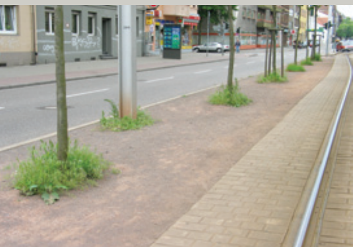
Exemple positif: Quai pour le tram à Sarrebrück (Allemagne). Malgré une utilisation intense et quotidienne par un nombre élevé d'utilisateurs, le quai est réalisé en substrat maigre. La végétation herbacée naturelle apparaît aux endroits où la circulation piétonne est moins fréquente.
