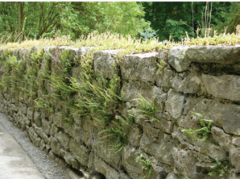
Mur en maçonnerie sèche à Manternach.
