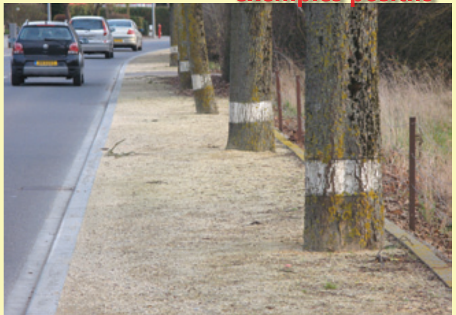
Trottoir en concassé à Foetz: l'aménagement d'un trottoir en concassé permet de conserver des rangées d'arbres existantes.
