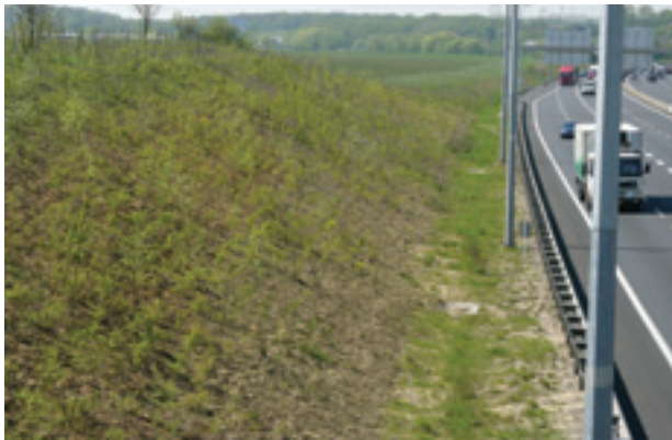
Exemple négatif: Recouvrement du talus avec de la terre arable et installation de la végétation par plantation.
