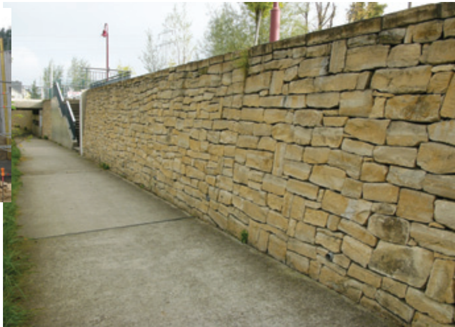
Exemple négatif: Faux-murs en maçonnerie. Il aurait fallu renoncer au revêtement du mur en béton, en premier lieu pour des raisons d'économie. Il faudrait construire ou bien un mur en maçonnerie (sèche ou traditionnelle) ou bien un mur en béton apparent.
