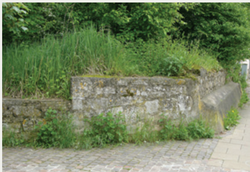
Exemple positif: Mur le long d'un trottoir à Bettembourg avec à son pied une bande herbacée naturelle qui a pu s'installer spontanément comme suite à la renonciation aux herbicides par l'Administration communale.
