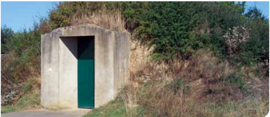
Réservoir souterrain à Peppange en 2013 / Wassererdbehälter in Peppingen im Jahr 2013
