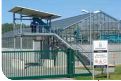
Station d'épuration, Peppange, env. 1,7 km Kläranlage Peppingen, ca. 1,7 km
