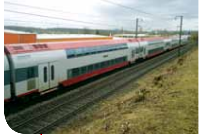
Ligne ferroviaire, Bettembourg-Luxembourg, env. 1,4 km Bahnlinie Bettembourg-Luxembourg, ca. 1,4 km
