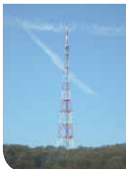
Emetteur Dudelange, env. 8,5 km Fernsehturm Düdelingen, ca. 8,5 km
