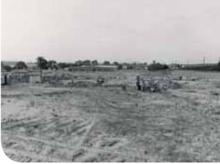
Entre la rue de Bettembourg et la ligne ferroviaire avec vue en direction sud-ouest Zwischen Rue de Bettembourg und Eisenbahnlinie mit Blickrichtung nach Südwest
