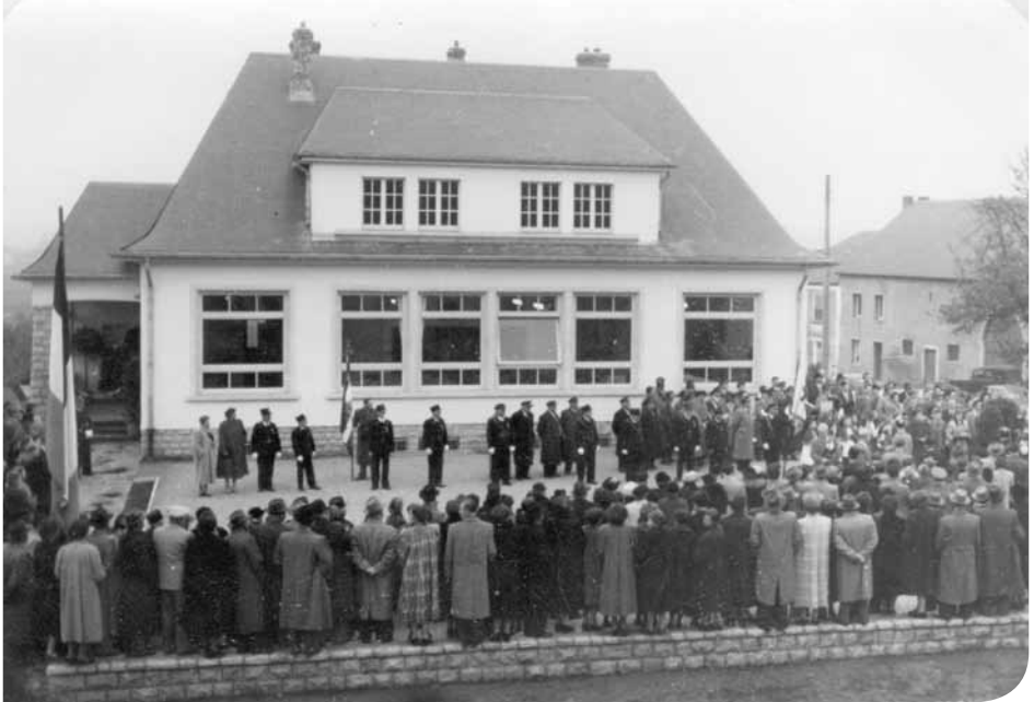
Inauguration de la nouvelle école le 8 novembre 1953. La cour de l'école a été entourée d'un mur. Einweihung der neuen Schule am 8. November 1953. Der Schulhof wurde mit einer Mauer eingefasst.
