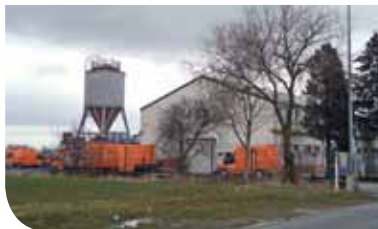
Service des régies Bettembourg, env. 3,6 km Regiebetriebe Bettemburg, ca. 3,6 km
