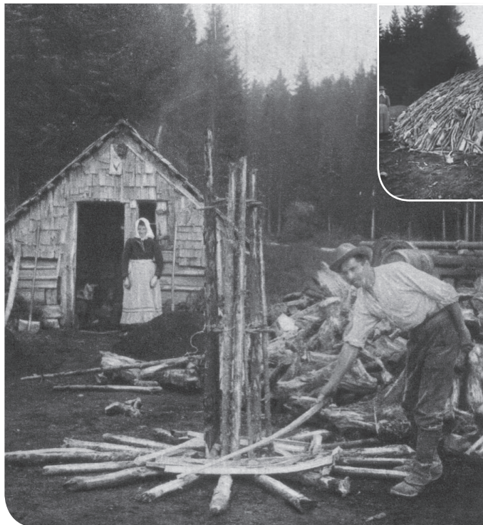
Construction de la cheminée centrale Bau des Luftschachtes
