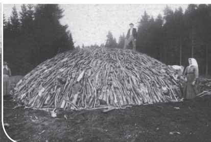
Empilage du bois en meule Zum Meiler aufgeschichtetes Scheitholz
