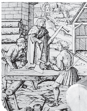
L'ouvrier du bâtiment Die Bauhandwerker
