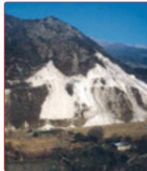
Le sentier de la corniche à Cuesta de Mal Paso, avant et après l'éboulement causé par les travaux Der Berghang am Cuesta de Mal Paso, vor und nach dem durch die Arbeiten verursachten Erdbeben
