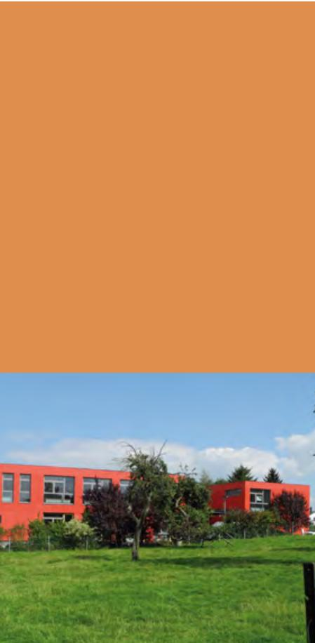
La réalisation de ce projet ambitieux en seulement 2 mois était possible, d'une part grâce au recours à la technique du préfabriqué modulable qui permet d'ériger un bâtiment dans des délais très courts sans pour autant devoir renoncer au confort d'une construction traditionnelle, d'autre part grâce à une planification minutieuse par le personnel du service technique communal et de l'entreprise Paul Wurth Geprolux.
