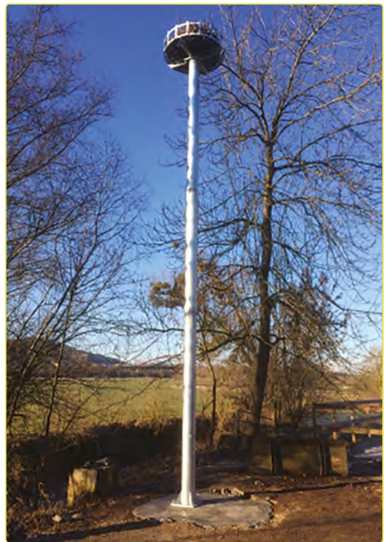
Horstplattform auf Metallmast / Plate-forme de nidification sur mât métallique
